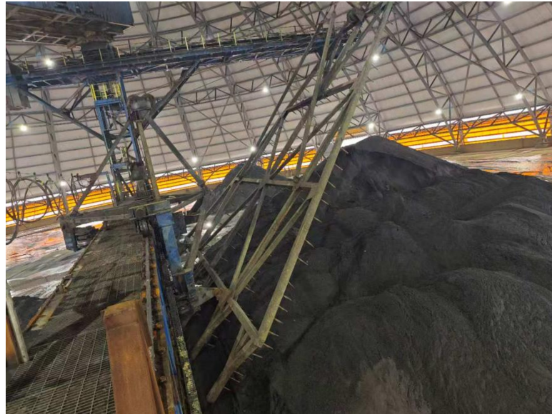
图 7 料耙结构现状
